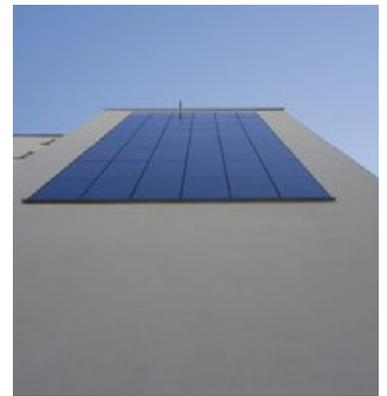
Im Rahmen einer Modernisierung wurde in 36 Häusern ein Energiekonzept bestehend aus Blockheizkraftwerken und erneuerbarem Strom aus Photovoltaik-Modulen umgesetzt. Die 100 qm große Photovoltaik-Anlage fügt sich jeweils harmonisch in das Gesamtbild des Gebäudes ein.
