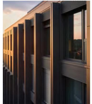
Sieben geschossiges Bürogebäude mit Nutzungsmischung aus Büroflächen, Arztpraxen und anderen Dienstleistungen in neuartiger Holz-Beton-Hybrid-Bauweise; Energieeffizienzhaus KW55 mit einer kompletten Solarfassade als Verkleidung.
