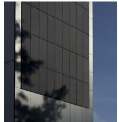
**Umbau der Südost-Fassade des Versorgungsunternehmens zur energetischen Fassade mit anthrazit-farbenen SKALA-Modulen.**
